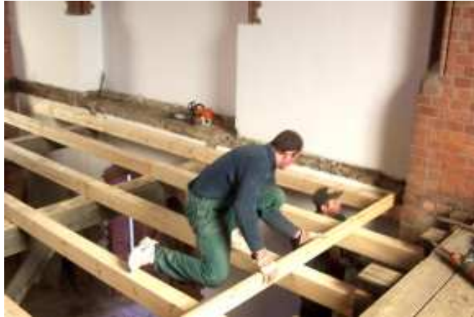
2008: Wir vergaben den Auftrag zur Erneuerung der Emporen, und gerade in diesem Augenblick wird es Gewissheit, dass die Ev. Lutherische Kirche in Detmold uns ihre Konzertorgel schenkt. Wegen der Höhe mußte im Orgelbereich der Boden um 35 cm abgesenkt werden.
