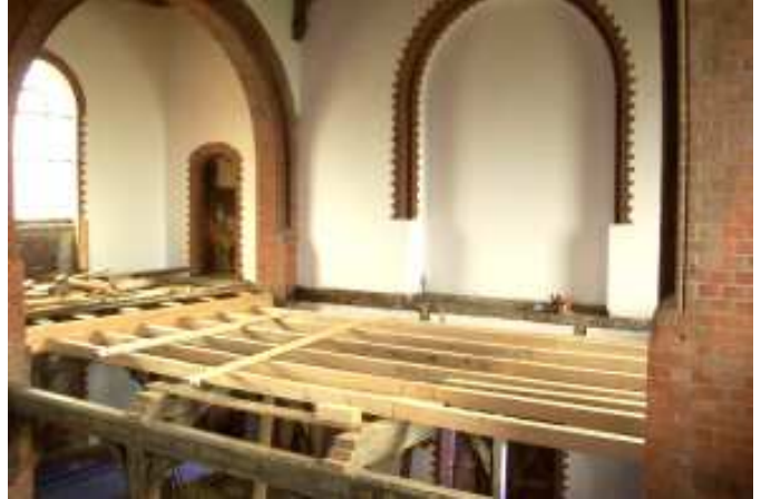
2008: Wir vergaben den Auftrag zur Erneuerung der Emporen, und gerade in diesem Augenblick wird es Gewissheit, dass die Ev. Lutherische Kirche in Detmold uns ihre Konzertorgel schenkt. Wegen der Höhe mußte im Orgelbereich der Boden um 35 cm abgesenkt werden.
