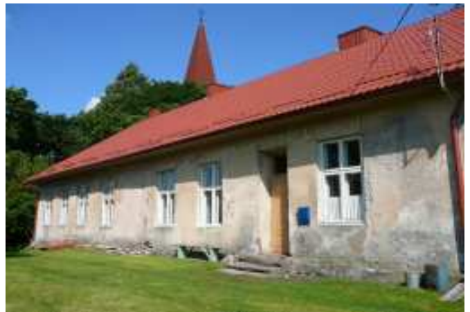
Um auch das Pfarrhaus zu erhalten finanzierten wir die komplette Erneuerung des Daches und der Schornsteine.
