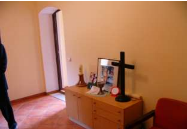
Völlig neu die Sakristei. Eine Ruine, ohne Wände, Zimmerdecke, Türen und Fenster hatten wir vorgefunden.
