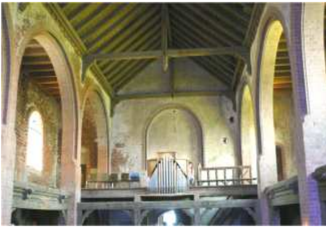
2007: Jetzt konnten wir auf das Geld für die Renovierung der Eingangswand bereit stellen und den Auftrag vergeben..
